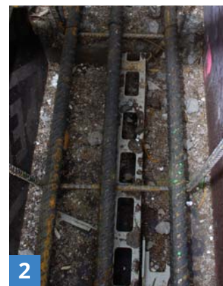
Nečistoty v bednění
