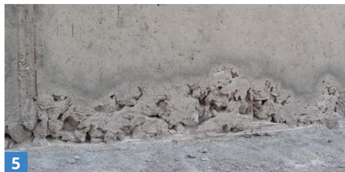
Odtok cementového mléka
