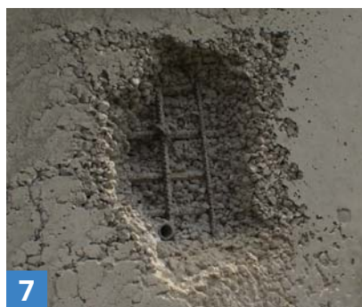
Obnažená armatura a štěrkové hnízdo
