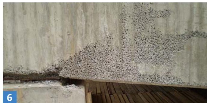
Štěrkové hnízdo, odtok cementového mléka
