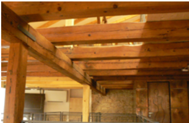
Realizace protipožárního nátěru FG700 FLAMGARD TRANSPARENT
