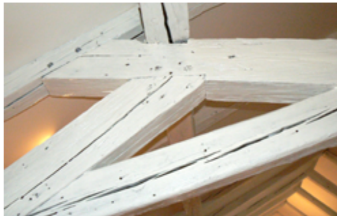
Realizace protipožárního nátěru FG500 FLAMGARD
